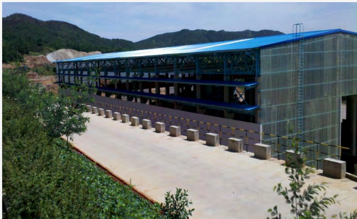
驰宏综合利用固体废物贮存库
