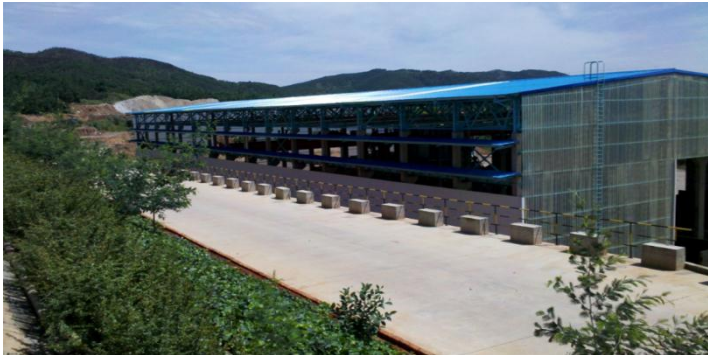
驰宏综合利用固体废物贮存库
