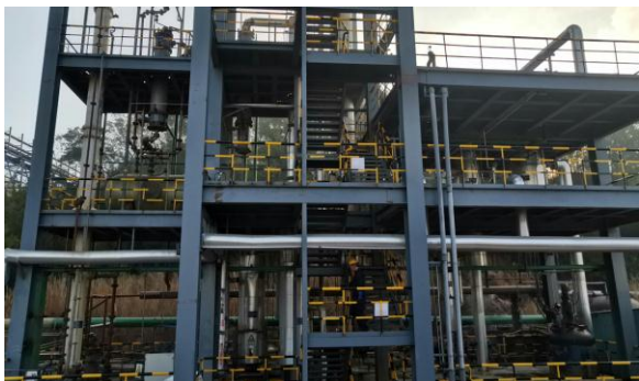
驰宏锗业废酸处理技改项目
