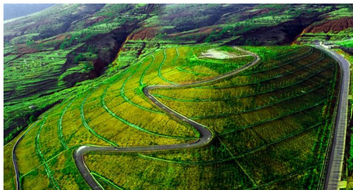
驰宏会泽分公司大渣堆就地处置示范工程
