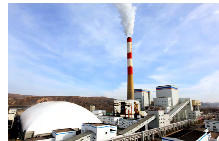
宁夏能源六盘山热电厂实施全封闭煤场技改
