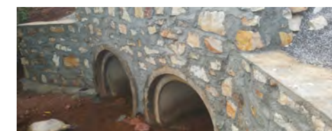
修缮桥梁、涵洞
