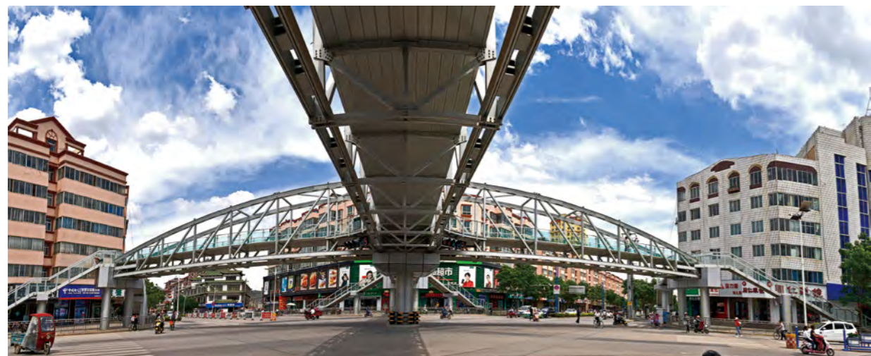
西北铝建成国内最大、甘肃首座 X 型桁架式铝合金天桥
