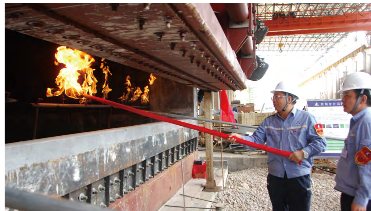
2019年7月1日，作为“三退三进”转型升级标志性项目的贵州分公司合金化首条生产线比计划工期提前两个月点火烘炉
